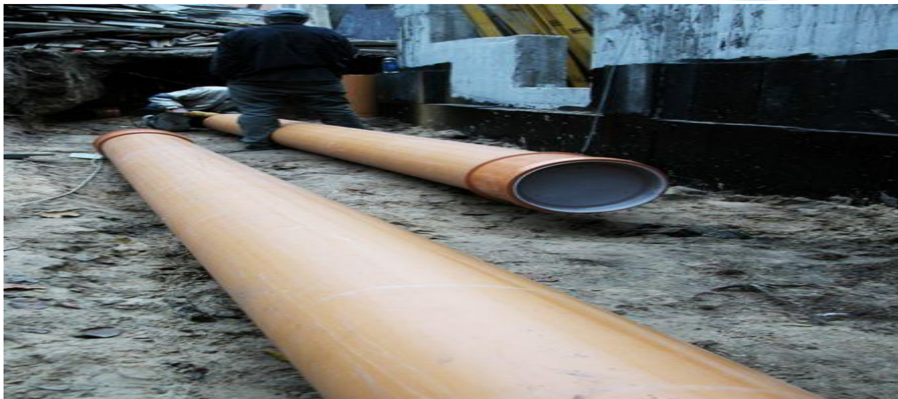
Пример грунтового теплообменника
