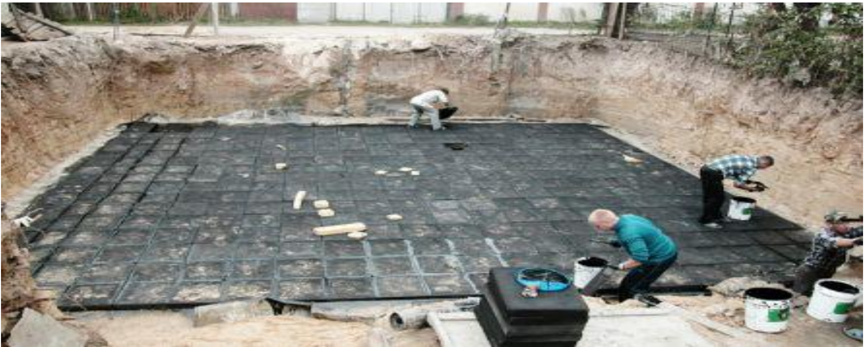
Пример утепления и гидроизоляции под фундаментной подушкой
