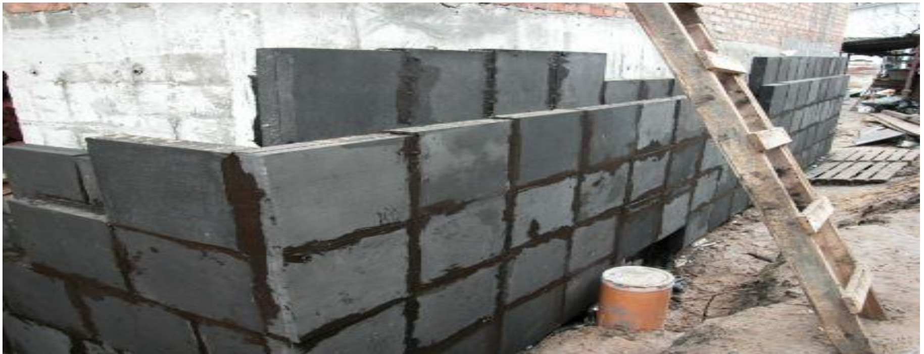
Наружная изоляция стен пассивного дома
